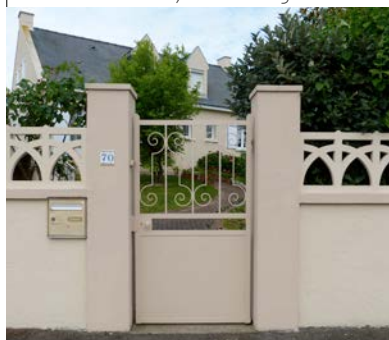
Clôture en ciment armé peint, des années 1930 à 1960. Saint-Géréon, Bd Montaigne.
