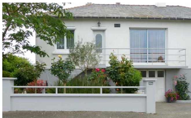
Clôture représentative des années 1950-1960, muret peint avec couronnement et lisse métallique. Saint-Géréon, Av de la Rougeaudière.
