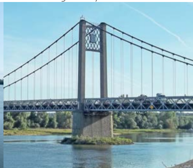
Les ouvrages d'art, Pont Bretagne-Anjou.
